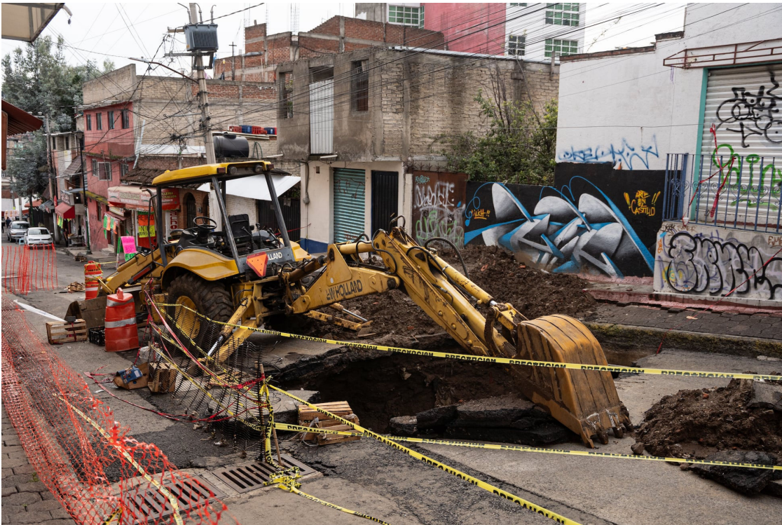
Trabajos en un mega socavón, en la Magdalena Contreras. Aurea Del Rosario
