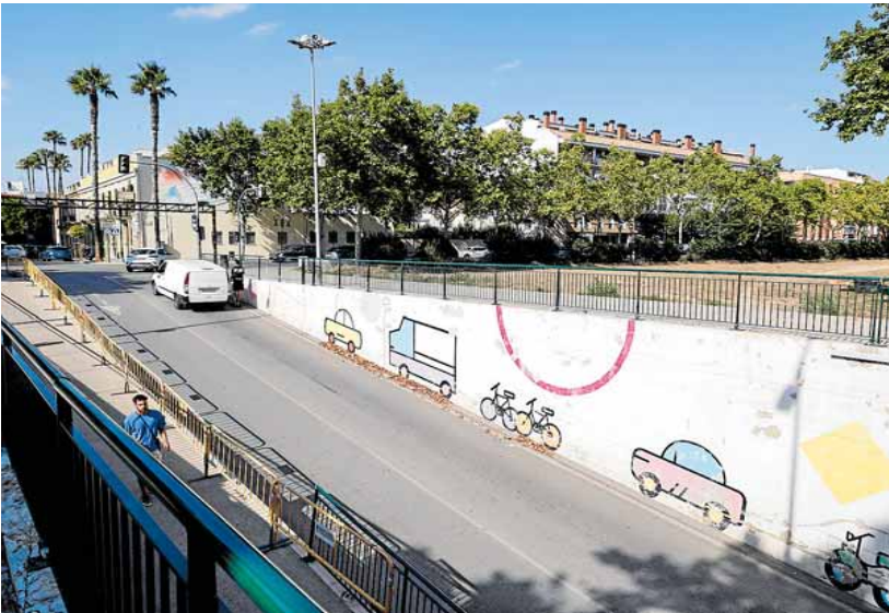
Interrupción de la Saleta por un paso inferior en Aldaia. J. SIGNES
