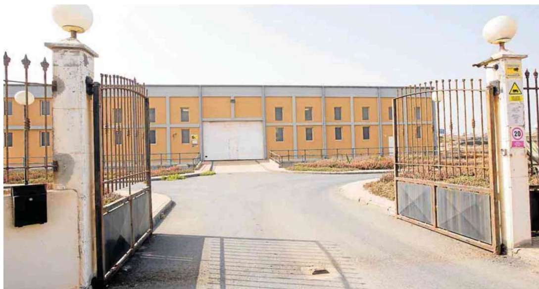
Entrada a las instalaciones de la estación depuradora de aguas residuales de Jinámar. c7
